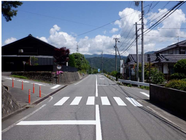
白線引直し・カーブミラー盤取替 （市道小鍛冶線、美女ヶ森付近）
