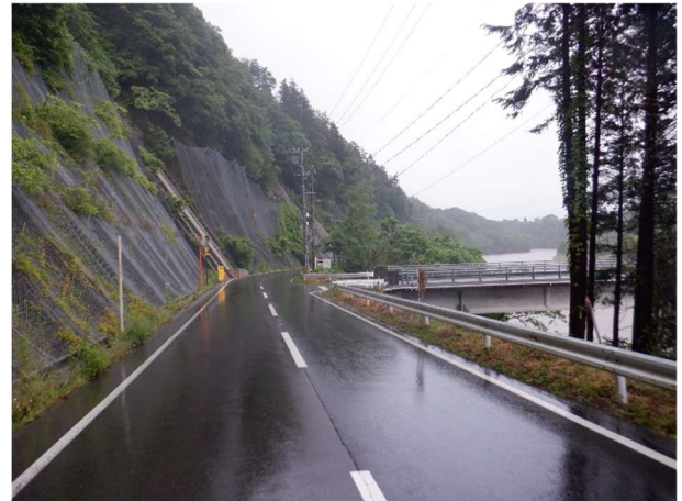
支障木伐採による視距確保 （県道伊那生田飯田線、小鍛冶大橋）
